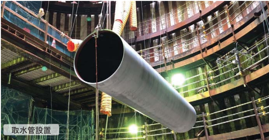
SA用海水ピット取水管設置工事
