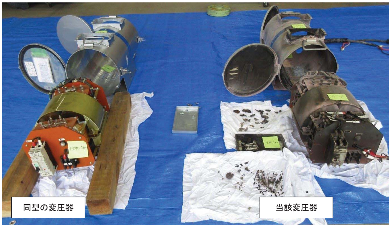
当該変圧器合同調査時の写真（９月１５日実施）
