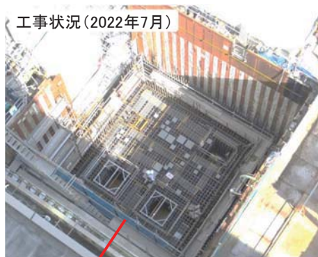
躯体工（鉄筋コンクリート施工）の様子
