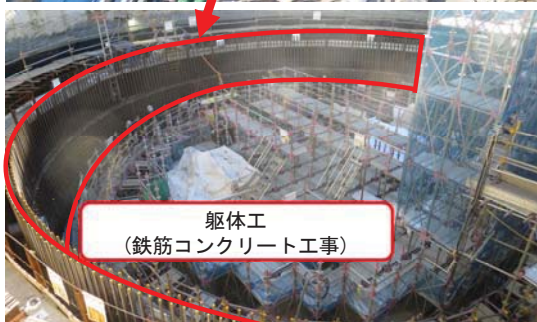
①代替淡水貯槽の工事状況
