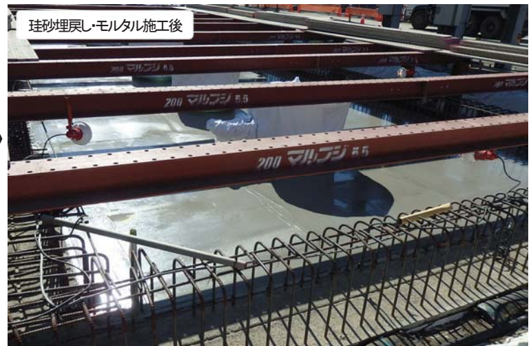
重油貯蔵タンクの工事状況
