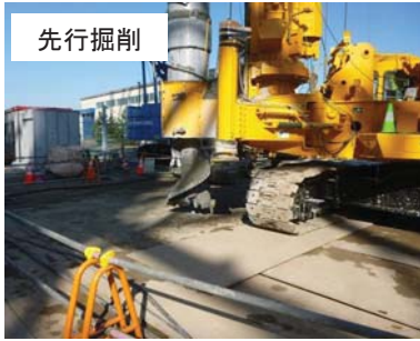
鋼管杭打設作業
