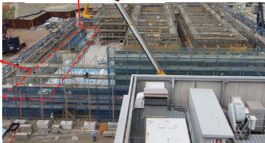
常設代替高圧電源装置置場の工事状況
