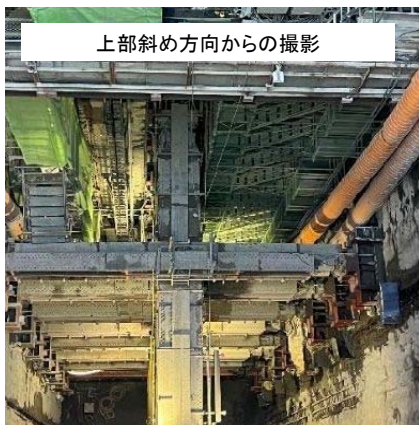
北基礎掘削の状況
