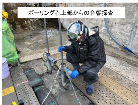
コンクリートの充填状態を確認するための音響探査及びコア測定の状況
