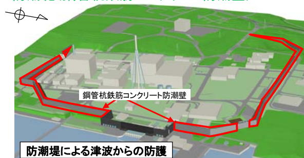
防潮堤(鋼管杭鉄筋コンクリート防潮壁)
