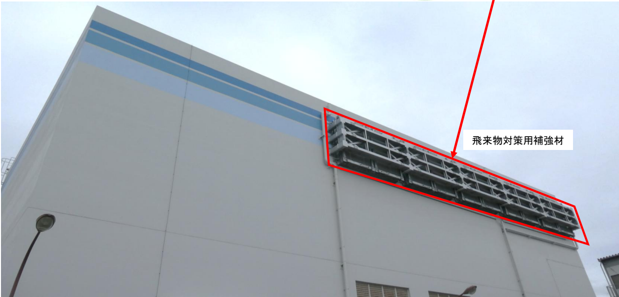
使用済燃料乾式貯蔵建屋外観
