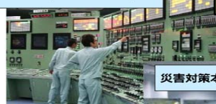
中央制御室(シミュレーター)対応
