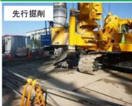
鋼管杭打設作業
