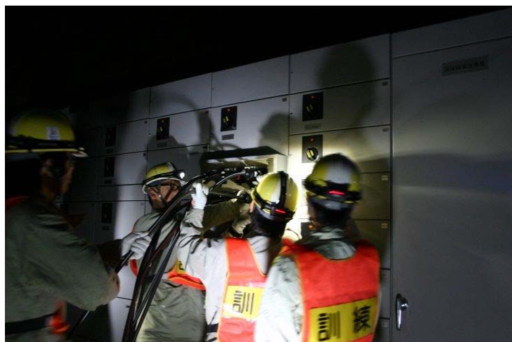
電源ケーブル接続訓練 (夜間訓練)
