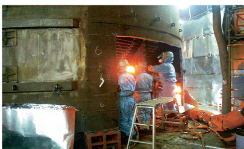
【熱交換器撤去工事：人手切断】
