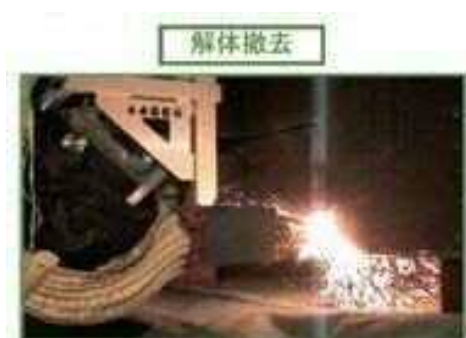
【熱交換器撤去工事：遠隔切断】
