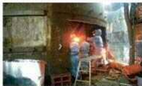
【熱交換器撤去工事：人手切断】
