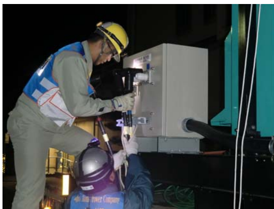
〈電源車へのケーブル接続〉
