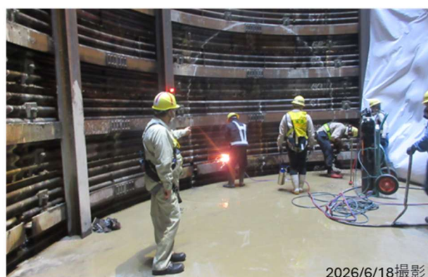
立坑内部から調査坑掘削を開始
