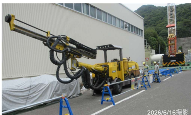
調査坑掘削用ドリル機
