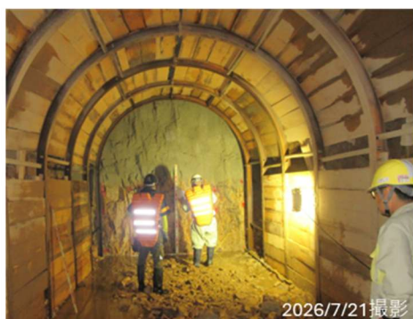
調査坑掘削状況
