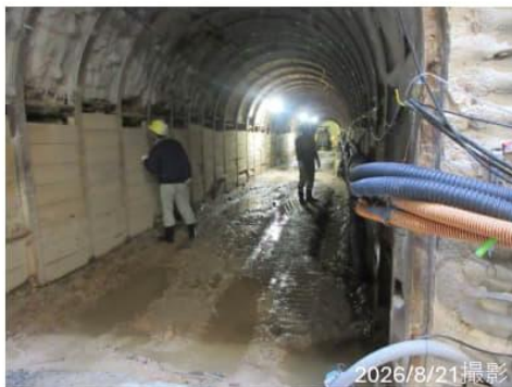
調査坑掘削状況
