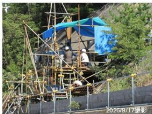
【K断層の分布と性状】 D-1トレンチでのボーリング
