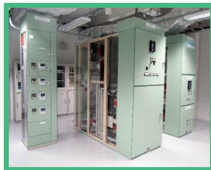
電気機器訓練室
